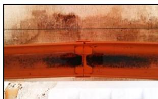
←クロルピクリン錠剤処理時、熱によって変形するため排水樋は被覆から出す
