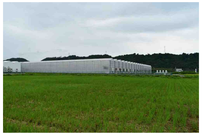
南から見た生産施設です。
