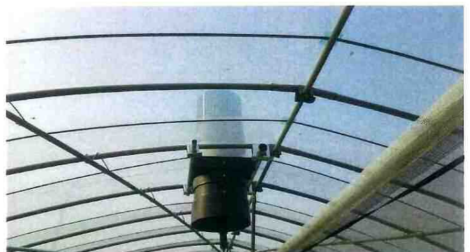
支持パイプを38φで補強
