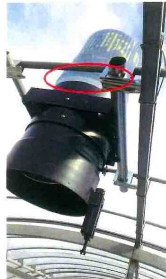
赤枠・・・フィルムがタートルネック状になり、雨の侵入を防ぐ。
