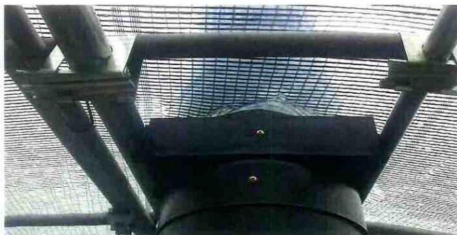
外張り遮光ネットの取り付け風景(浜松市) ↑ ↓
