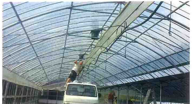
熊本県 設置の様子
