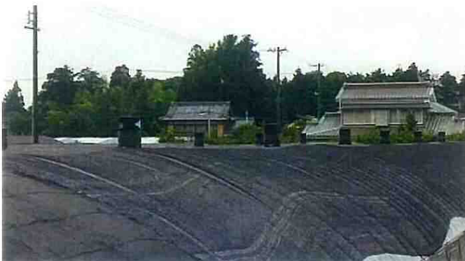
外張り遮光ネットの取り付け風景(浜松市) ↑ ↓
