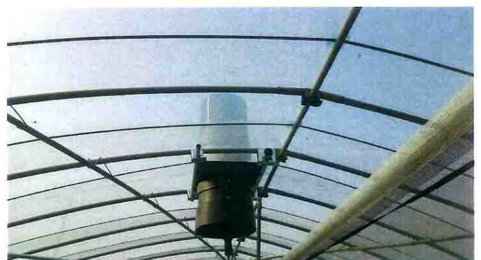
支持パイプを380で補強
