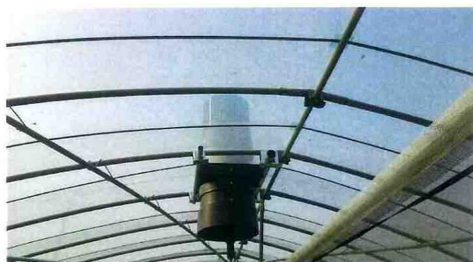
支持パイプを38φで補強
