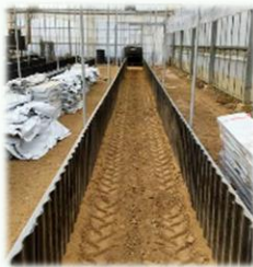
杵板ベッド完成
